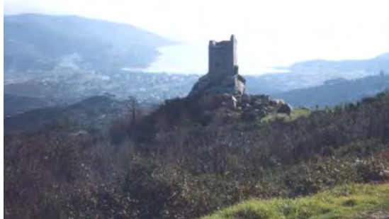
Localizzazione della torre
