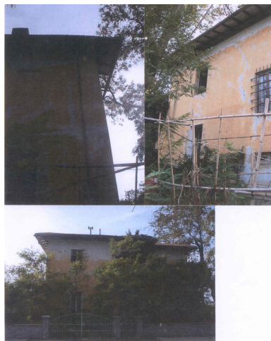
l'edificio della caserma
