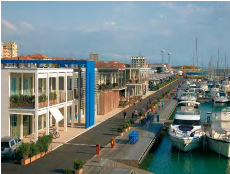
Fotografia 5. Il completamento del nuovo porto di Crepatura (Cala dei Medici) ridisegna la linea di costa in prossimità del naturale cambio del litorale da roccioso a sabbioso.
