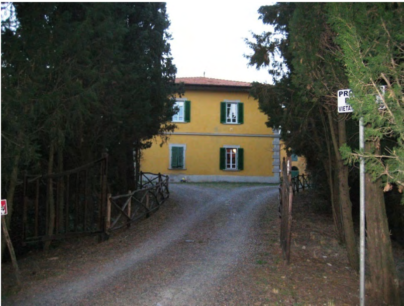
Fotografia 5. Antica struttura granducale oggi sede della Casa Forestale, punto di controllo della Riserva Biogenetica.
