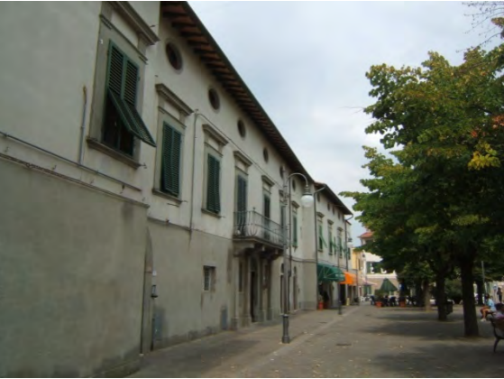
Fotografia 8. Villa Medicea di Collesalvetti, presidio all'origine delle trasformazioni della pianura bonificata.
