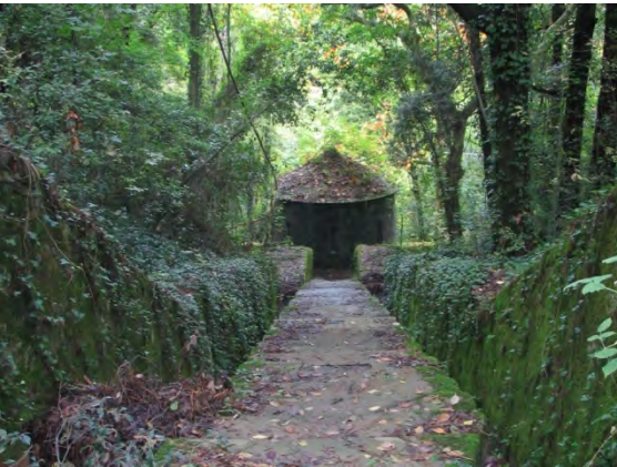
Fotografia 7. Le opere di presa alle Sorgenti dell'Acquedotto di Colognole.
