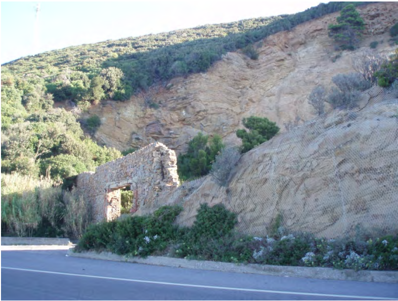
Fotografia 2. Affioramenti rocciosi di Macigno di Calafuria hanno indotto nella storia numerosi insediamenti estrattivi oggi abbandonati.
