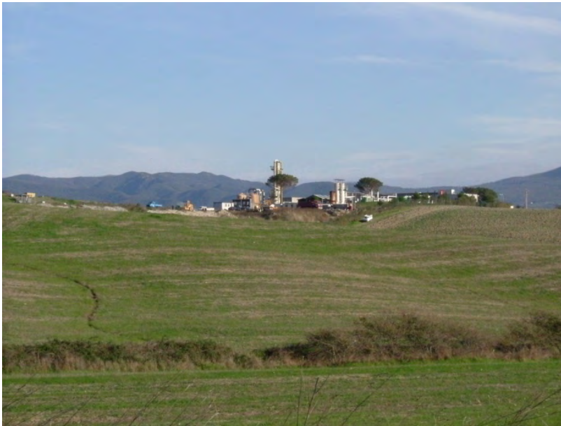
Fotografia 6. Le strutture degli impianti della discarica sono completamente privi di opere di mitigazione degli impatti.
