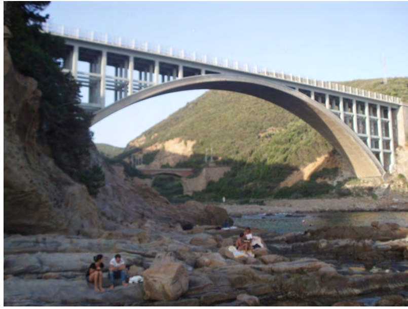
Fotografia 6. Il ponte di Calignaia rettifica e mantiene in quota l'andamento della strada litoranea del Romito.
