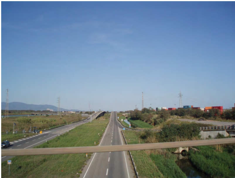
Fotografia 6. Le infrastrutture e gli impianti tecnologici a rete hanno condizionato pesantemente i caratteri paesaggistici delle aree limitrofe alla fascia urbana.
