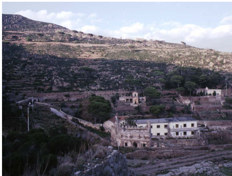
Fotografia 6. La colonia penale alle pendici del Monte Castello testimonia lo stato di abbandono e degrado delle strutture e delle sistemazioni idraulico-agrarie.
