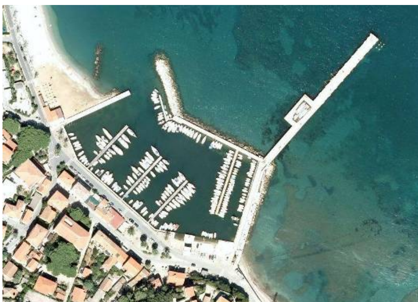
Foto aerea del Porto Turistico di Cavo (da Google)
