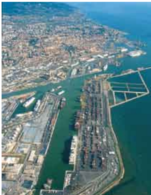
Veduta dall'alto del terminal containers Darsena Toscana
