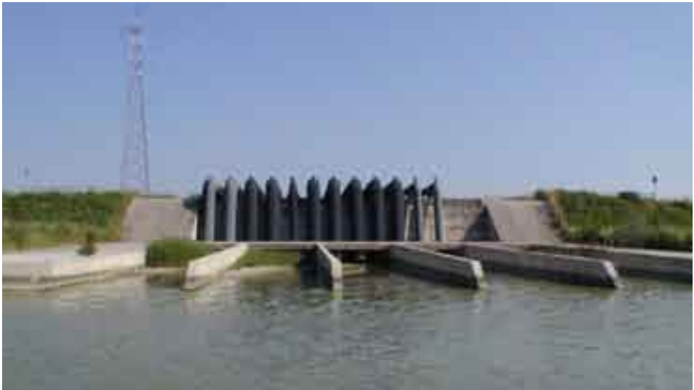
Idrovora per la bonifica della aree dell'Interporto
